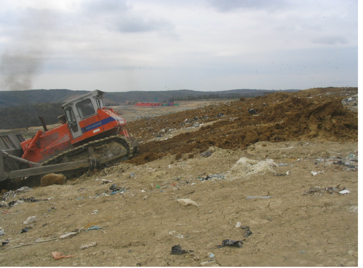
Fotoğraf 2. Yıpranmış örtü tabakasının ilave örtü ile tamamlanması (İSTAÇ,Odayeri,Dozer)
