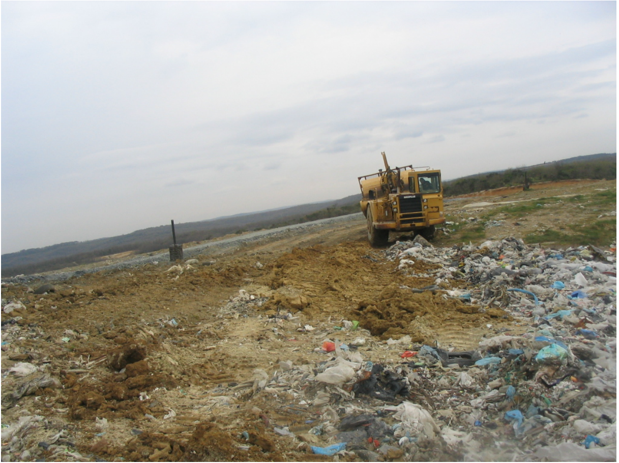
Fotoğraf 1. Yıpranmış örtü tabakasının ilave örtü ile tamamlanması (İSTAÇ,Odayeri, Scraper)
